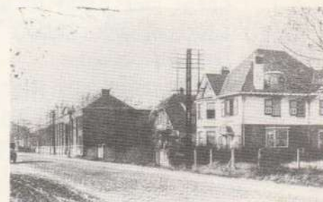
Van links naar rechts: de kazerne, de 'Normandie' en de villa waar nu 'The Upper Ten' is gevestigd (opname omstreeks 1930).
