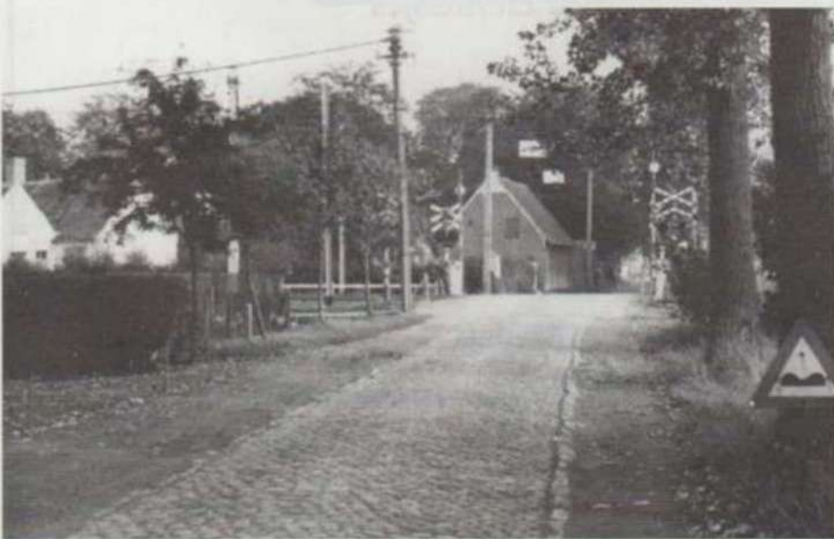
De poort naar het Hemelrijk. De vroegere spoorwegoverweg, nu vervangen door een brug.
