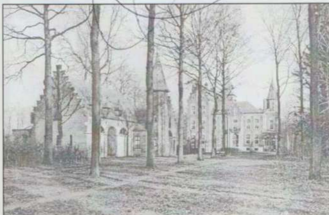
Foto 2. De mooie dreef naar het kasteel; aan de linkerzijde het koetshuis en het poortgebouw.
